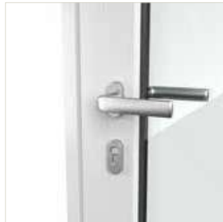
Puerta balconera practicable, con manilla y cerradura por el interior
